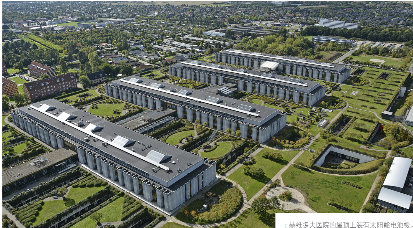
赫维多夫医院的屋顶上装有太阳能电池板。
