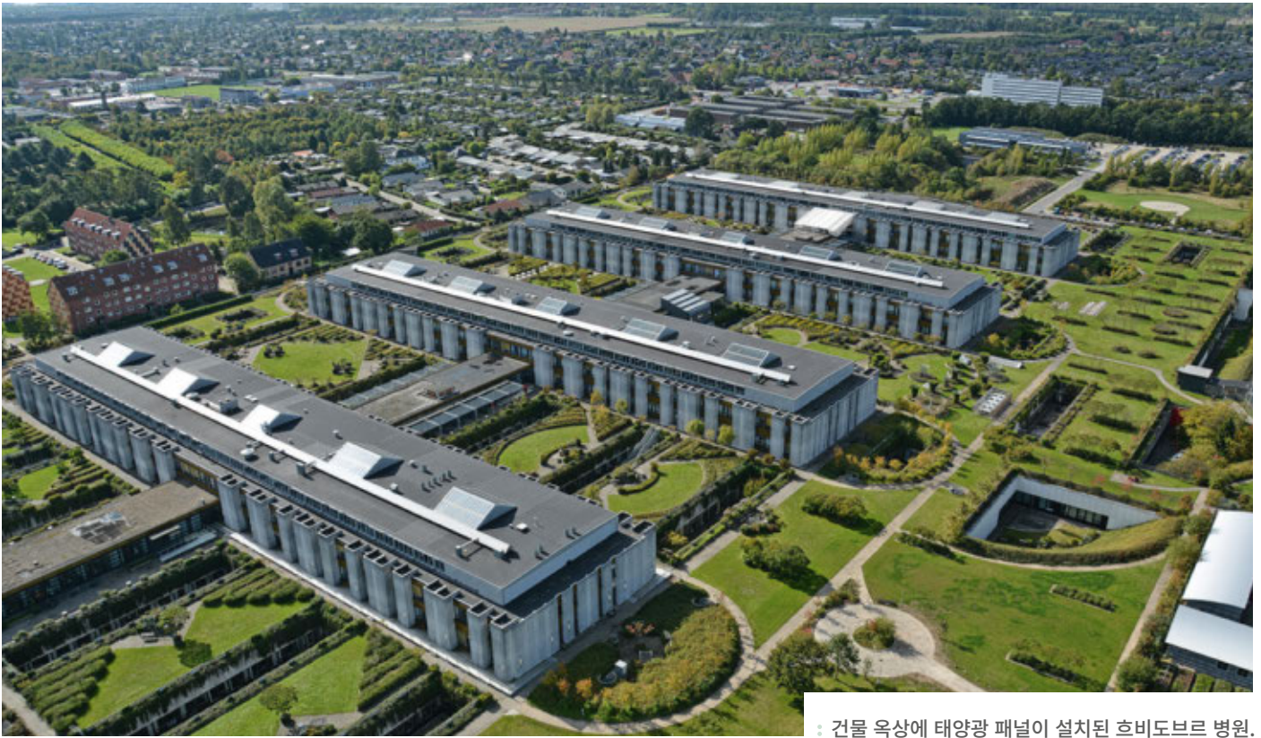
· 건물 옥상에 태양광 패널이 설치된 흐비도브르 병원.
